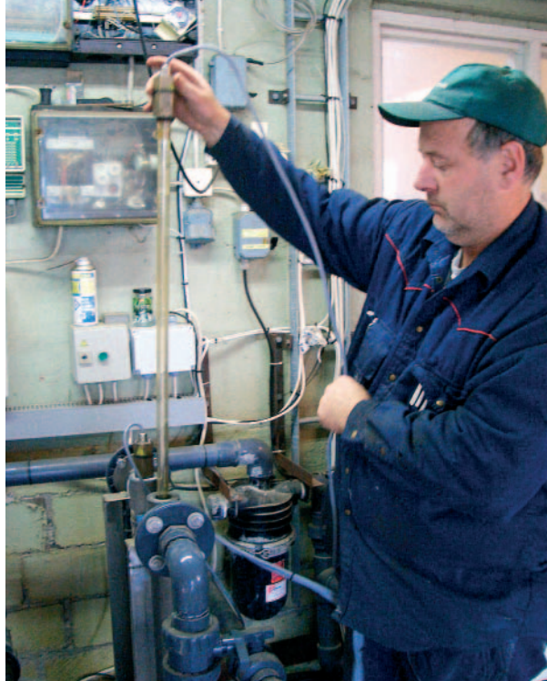
Ronny Svensson rengör UV-lamporna 1-2 gånger i veckan, för att få god reningseffekt av BenRad.
