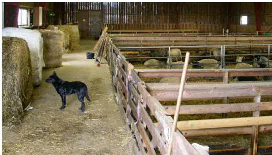
Färstall med tvärställda foderbord, glespanel i väggarna, plåttak och öppennock.
