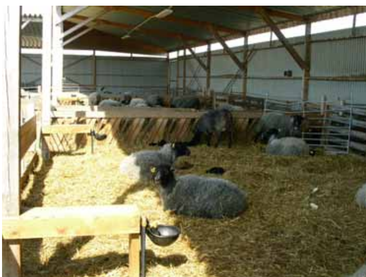
Vattenkoppar vid varje stolpe i framkant av byggnaden.
