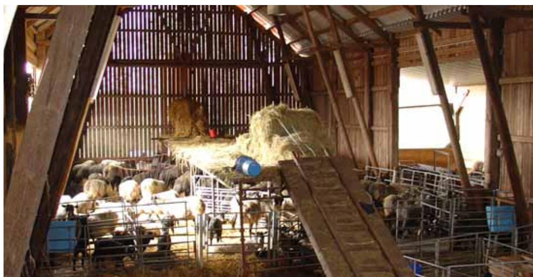
Arbets- och utfodringsramp mellan boxarna i logbyggnaden. Till höger skymtas taket på den tillbyggda delen.
