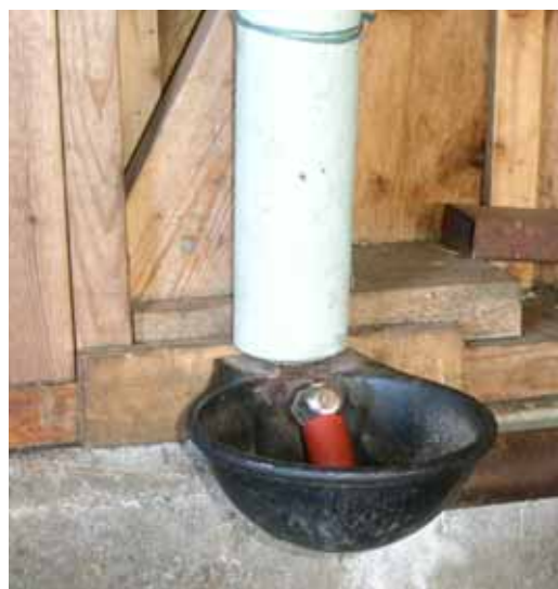
Vattenkopp med pendelventil, cirkulerande system.
