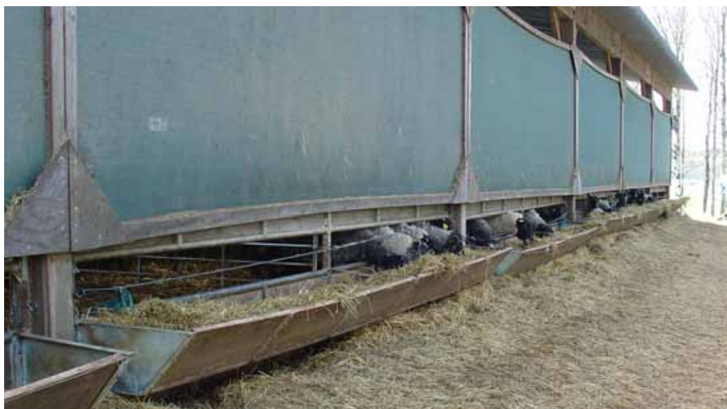
Foderkrubbor med utvärdig utfodring i tillbyggnaden. Vindväv i ramar som kan demonteras.
