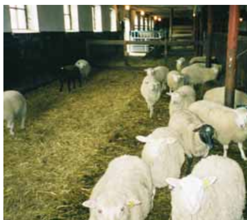
Ströbädden ligger direkt på det gamla betonggolvet och den gamla inredningen vid foderbordet fungerar fortfarande.
