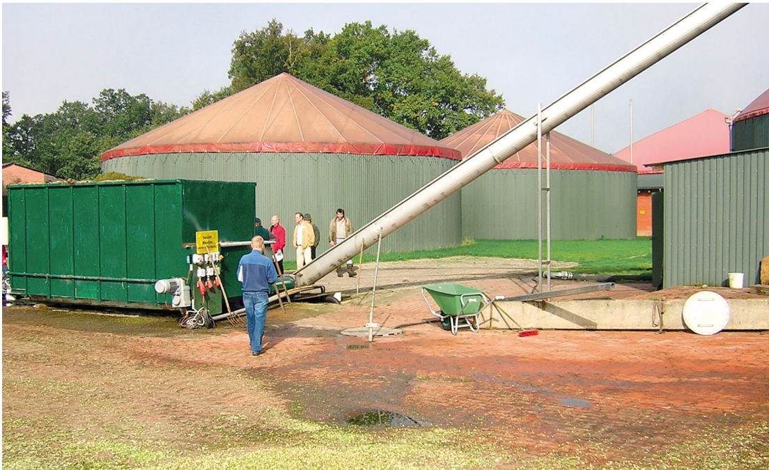
Biogasanläggning utanför Hannover i Tyskland där de rötar energigrödor. Foto: Kjell Christensson.
