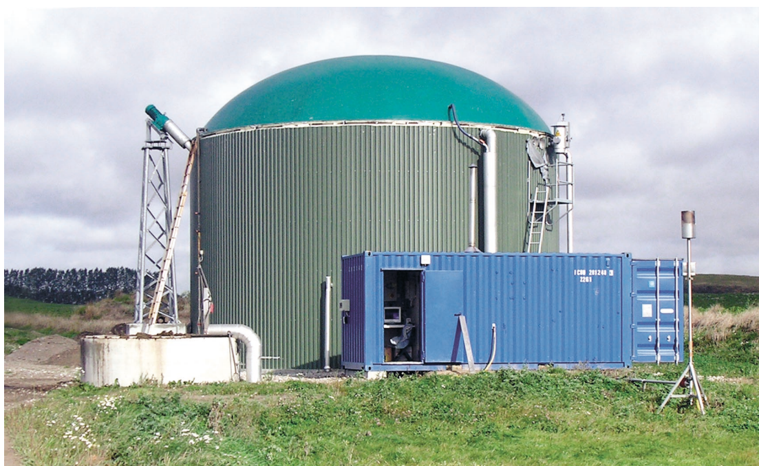
Hagaviks biogasanläggning. Foto: Anna Hansson.
