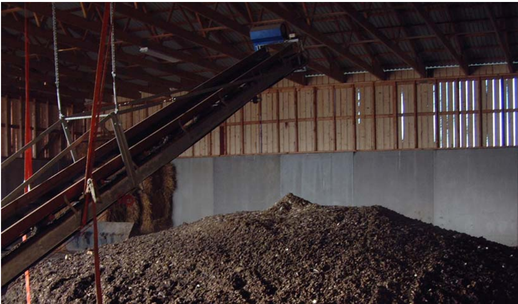
Stallgödsel är en värdefull växtnäringsskälla som också innehåller mycket återvinningsbar energi.
