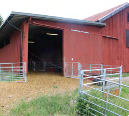
Fårhuset är en tillbyggnad på befintlig loge med måtten 33 x 7 meter. Byggnaden är förprovad för 80 tackor, men är optimalt för maximalt 43 vårlammande tackor enligt gårdens erfarenhet. Från början hade man grus som underlag, men efter några år investerades i en gjuten platta. Något som underlättat utgödslingen.
