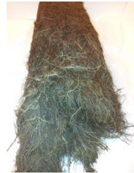
Rötter från träd som satt igen en dräneringsledning. Foto: Zivko Rasic.
