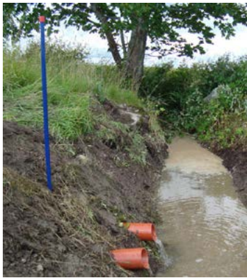
Träd får inte placeras nära dräneringsledningarna på fälten eller nära deras utlopp i diken. Foto: Rune Carlsson.
