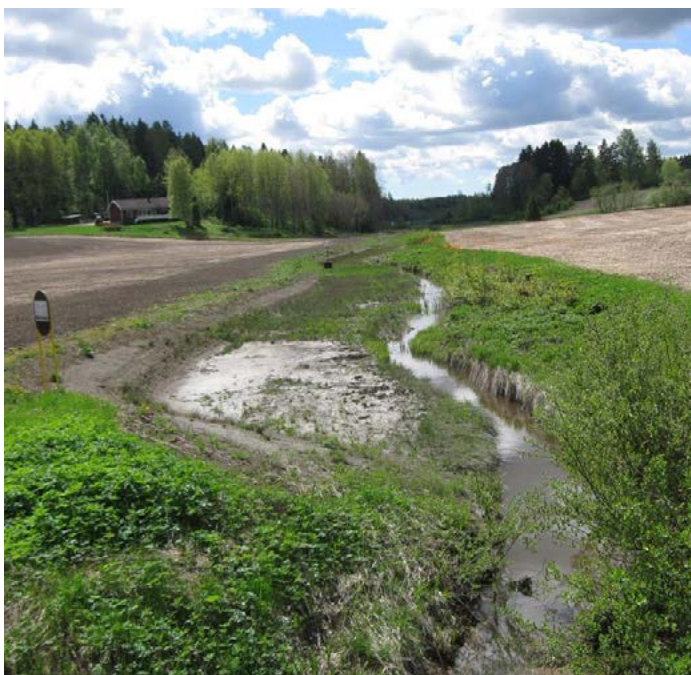
Figur 2. Tvåstegsdike, Finland, ett exempel på en åtgärd som beskrivs i rapporten. Foto: Jonas Svensson
