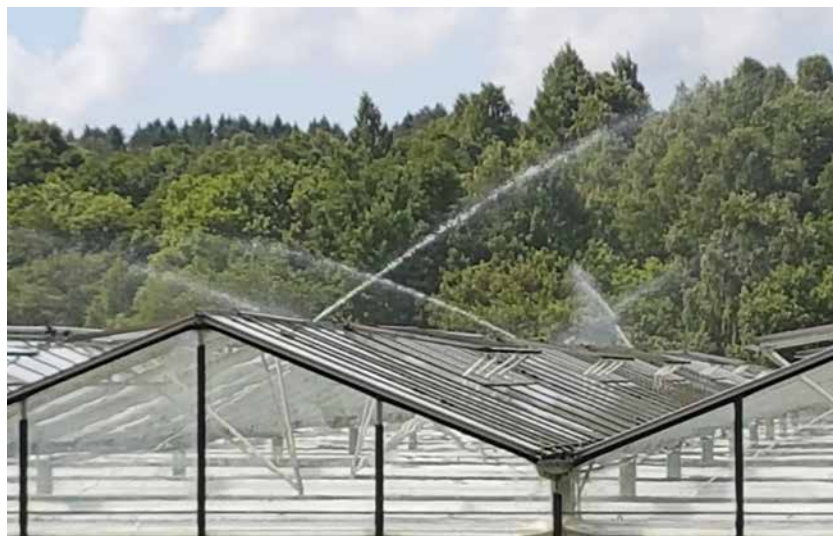
Sprinkler på taket höjer luftfuktigheten inne i växthuset med 3–5 procent. Foto: Torbjörn Hansson.
