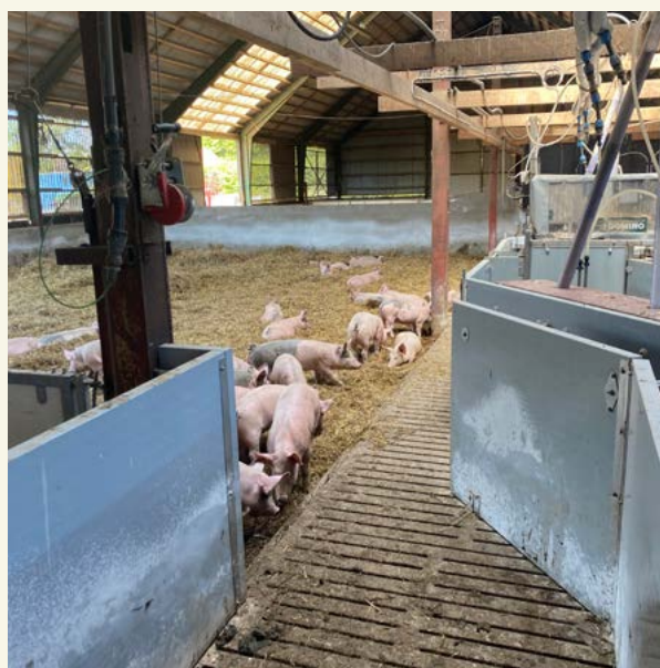
Ombyggnation av loge till vågstall.
