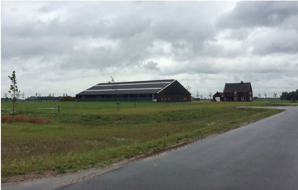
Overdiepse polder, Nederländerna. Bostadshus och stallar är byggda på platåer för att inte skadas av de kontrollerade översvämningarna. Foto: Tobias Markensten
