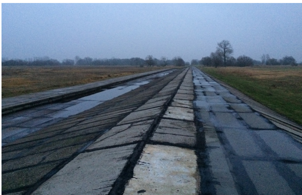
Poznan, Polen. Vattnet från ett vattendrag till höger utanför bild svämmar vid höga flöden över hindret och magasineras på jordbruksmarken till vänster. Eller? Foto: Tobias Markensten
