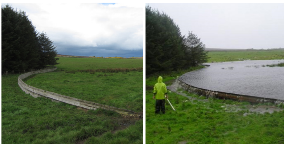
En del av en betesmark där en fördämning anlagts i rinnvägen. Vid kraftig nederbörd som leder till ytavrinning i svackan fylls volymen bakom fördämningen med vatten. Vid tillräckligt höga flöden stiger vattenytan till dess att den börjar strömma över. Bilden till vänster: Jennie Wallentin, bilden till höger: Belford project.
