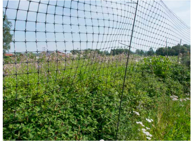
Nätstaket mot vilt.
