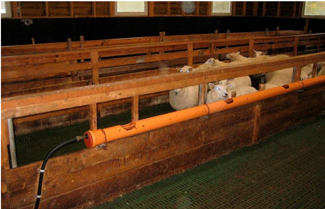
Bild 3. Vatten ges via rör som fästs på boxväggarna, från Lantbrukets byggnadsteknik, Fårstallplan. Foto Mie Meiner
