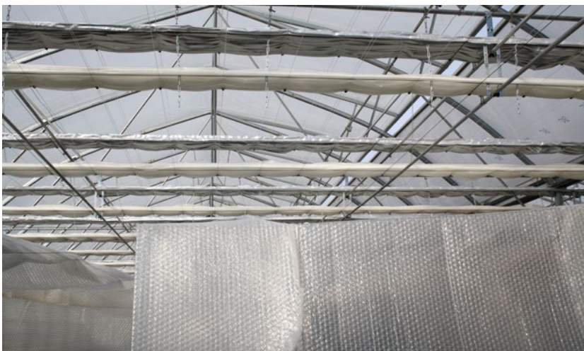
Energi- och skuggväv i taket jämnar ut temperaturer och bubbelplasten vid tidig plant-uppdragning minskar energibehovet. Foto: Elisabeth Ögren.
