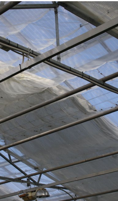
Öppna ventilationsluckorna först, innan du drar ifrån vävarna för att avfukta. Foto: Elisabeth Ögren.
