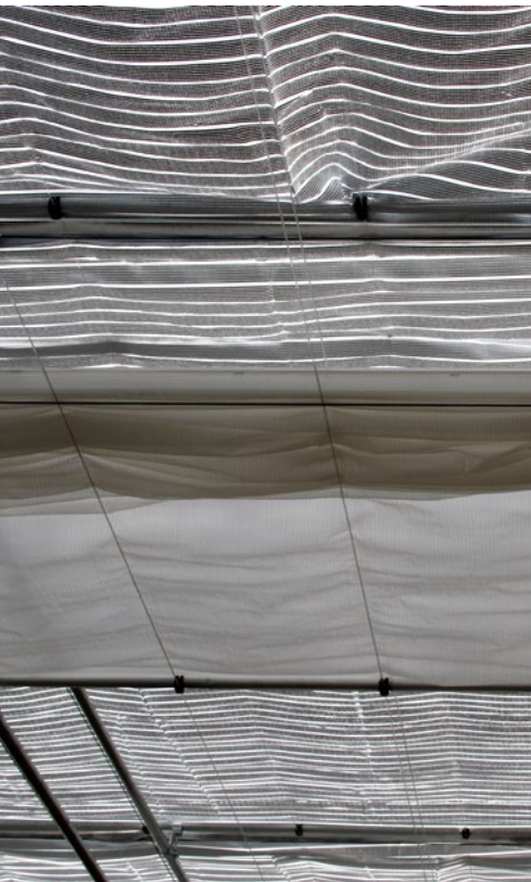
Alla vävtyper minskar effektbehovet och sparar energi. Här ser du skugg- och energiväv. Foto: Elisabeth Ögren.
