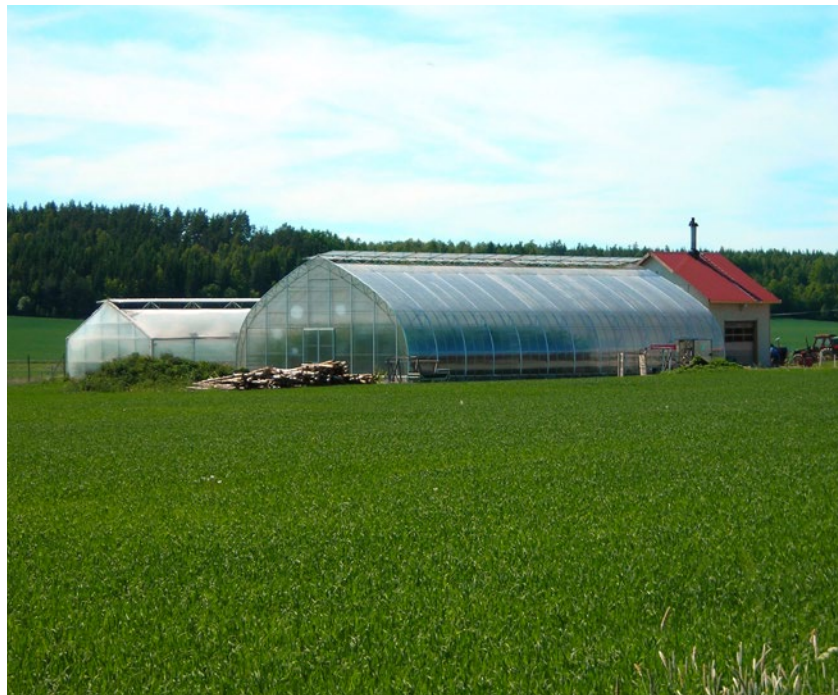
Ett avlångt växthus släpper in mest ljus från långsidan och bör placeras med nocken i öst-västlig riktning. Foto: Elisabeth Ögren.
