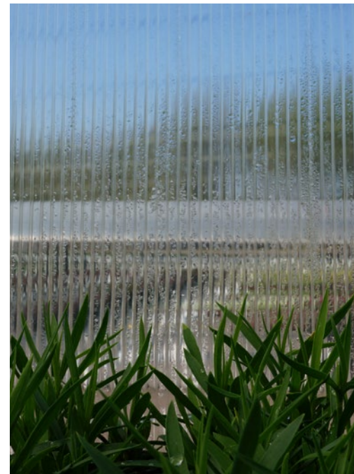
När luften kommer i kontakt med en yta med en lägre temperatur än luftens bildas kondensdroppar. Hög därför temperaturen långsamt för att undvika kondens. Foto: Elisabeth Ögren.
