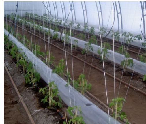
Perforerade slangar sprider luftburen värme. Foto: Elisabeth Ögren.
