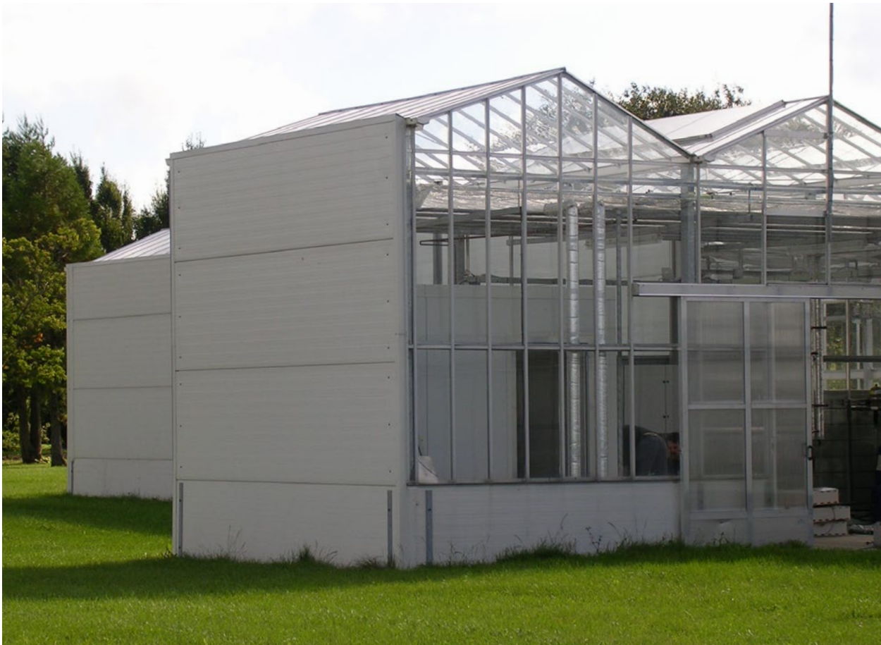
Exempel på helisolerad norrvägg från Årsløvs forsøksstation utanfor Odense i Danmark. Væggen er isoleret med væggpaneler 50 millimeter tjøkke med vit insida for bedste ljusreflektion.
