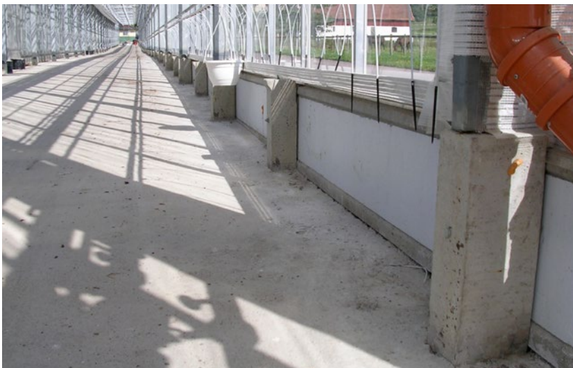
Plintgrund med isolerade sockelelement. Plintarna kan antingen vara färdiggjutna på fabrik och grävas ner, eller så gjuts de på plats.
