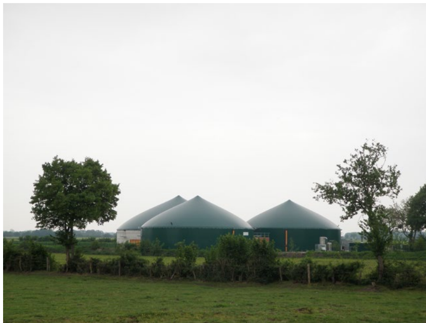
Biogasanläggning från Belgien.
