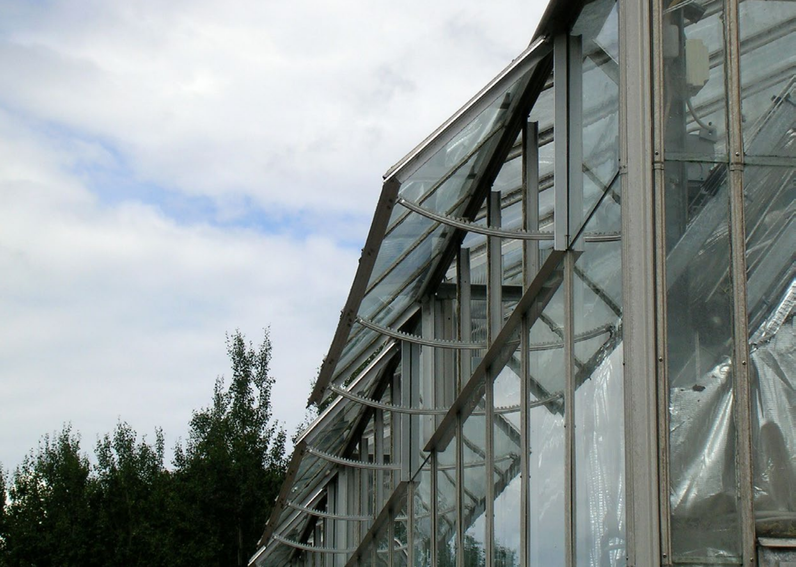
Fribärande hus med sidoventilationsluckor.
