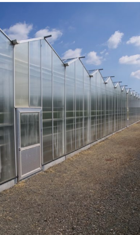
Venloväxthus med små ventilationsluckor. Det går numera att få genomgående ventilationsluckor även till venlohus.
