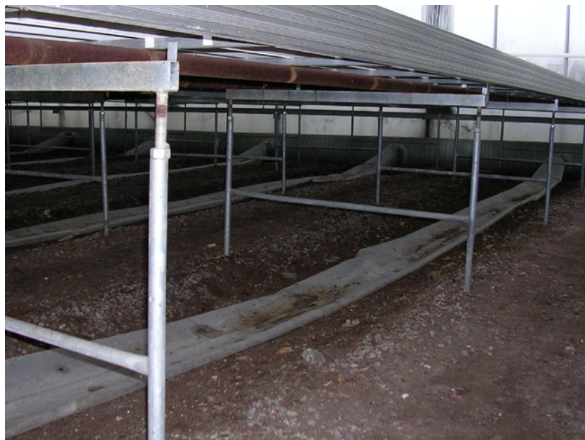
Plastfolieslangar under bord. Längs växthusets långsida, vid bordens kortsida, går en spirokanal. Vid varje bord finns ett uttag för en plastfolieslang. Samma princip används även vid radodling av grönsaker eller bär.
