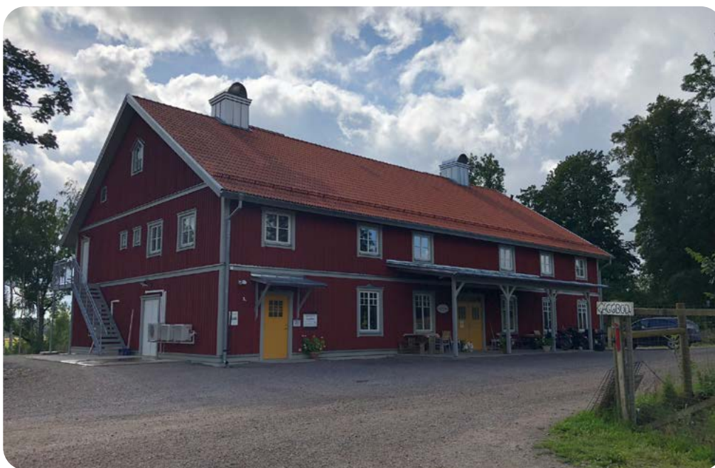
Berga Skafferi, det nybyggda huset rymmer äggbod, gårdsbutik, gårdscafé, konferensvåning och förädlingslokaler
