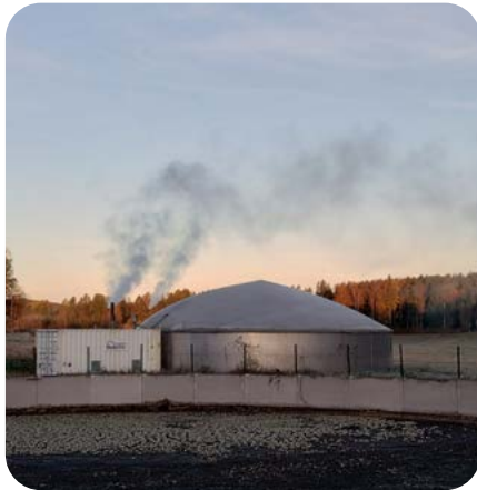
Biogasanläggningen i drift
