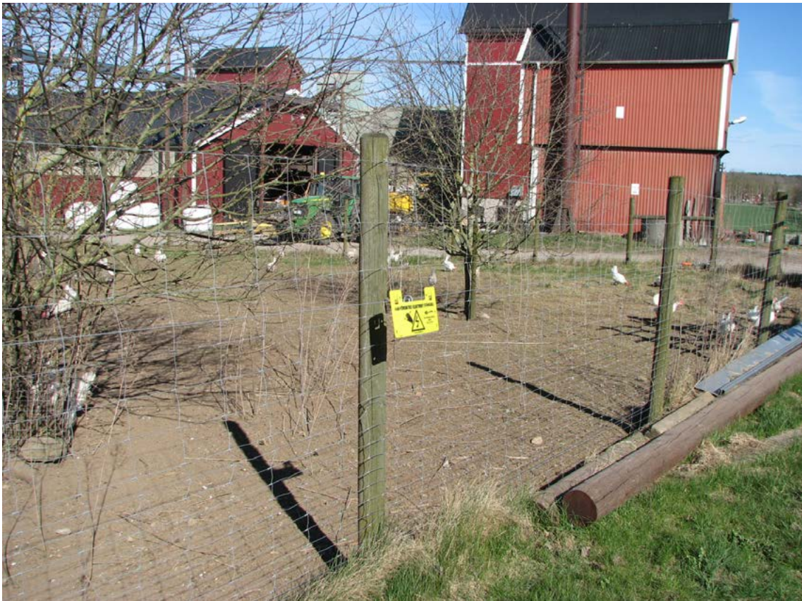
Viltstängsel kombinerat med två eltrådar, foto Åsa Odelros
