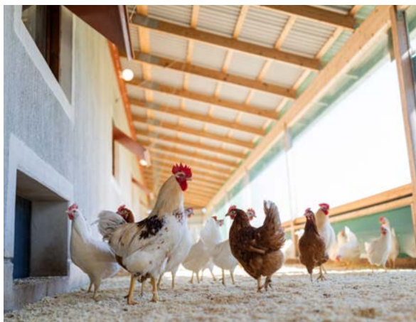
Utomhustillbyggnad med vindväv, gummiduk på långsidan samt träpanel på kortsidor, foto Lena Larsson
