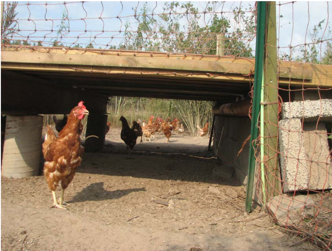
Hönstunnel under gårdsväg
