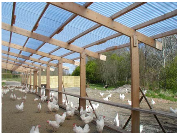
Oisolerad veranda med hönsnät på tre sidor, foto Åsa Odelros
