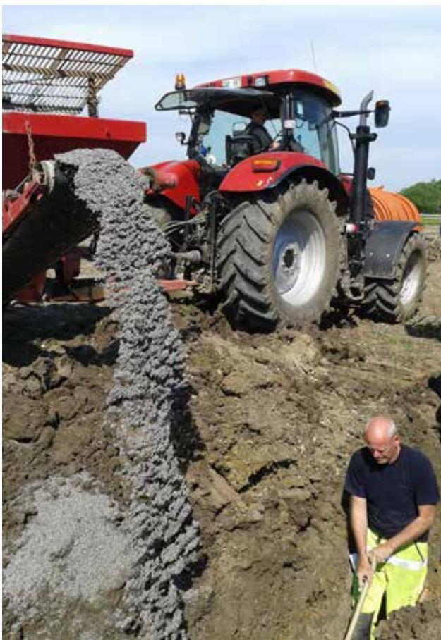
Påfyllning av filtermaterial. Foto Anuschka Heeb.
