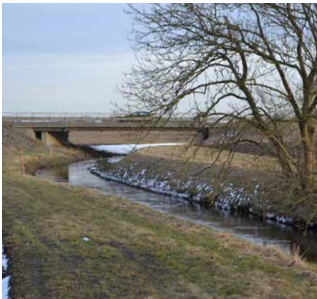
Det är viktigt att huvudavvattningen är väl underhållet. Foto Alva Agger.
