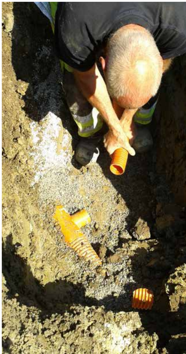
Inkoppling av en sadelgrenkoppling. Foto Anuschka Heeb.
