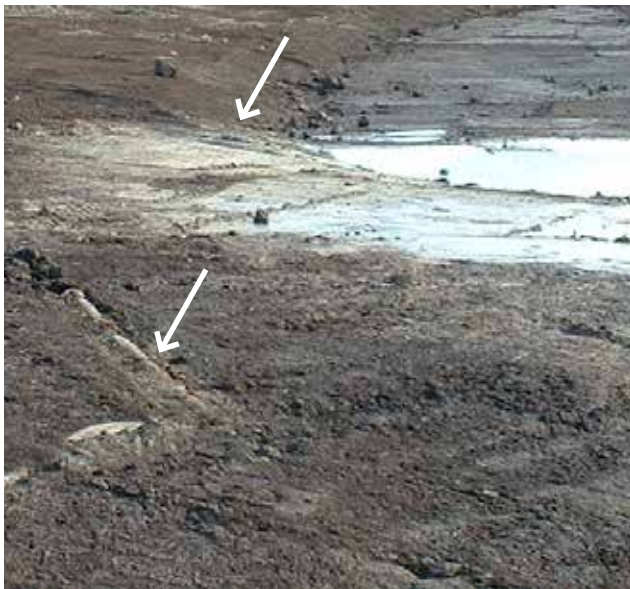
Glöm inte bort att hantera alla befintliga dräneringsledningar. Både för våtmarkens och dräneringens skull. Foto Tilla Larsson.
