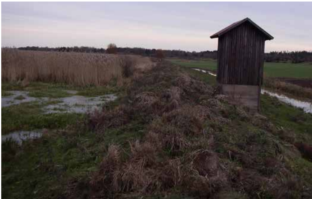
De lågt liggande markerna till höger skyddas mot vatten genom invallning. Vattnet pumpas från den lägre nivån genom eller över vallen och vidare ut till den högre nivån vänster om vallen. Foto: Stig Svenmar
