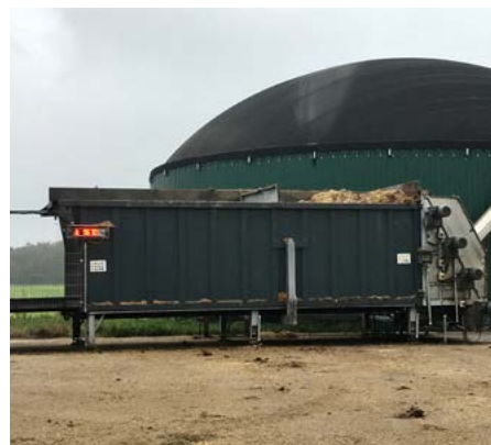
I denna biogasanläggning rötas bland annat djupströgödsel och grönmassa från ekologiska vallar. Foto: Pauliina Jonsson.
