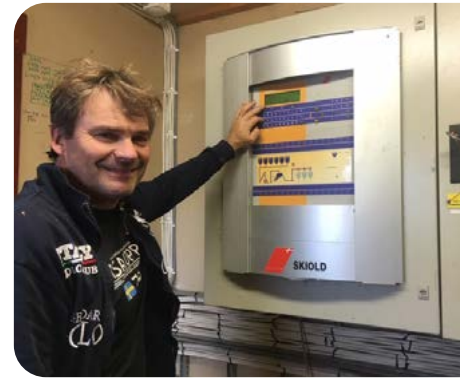
Mats vid foderdatorn. Det måste vara lätt att korrigera kraftfodrets sammansättning.
