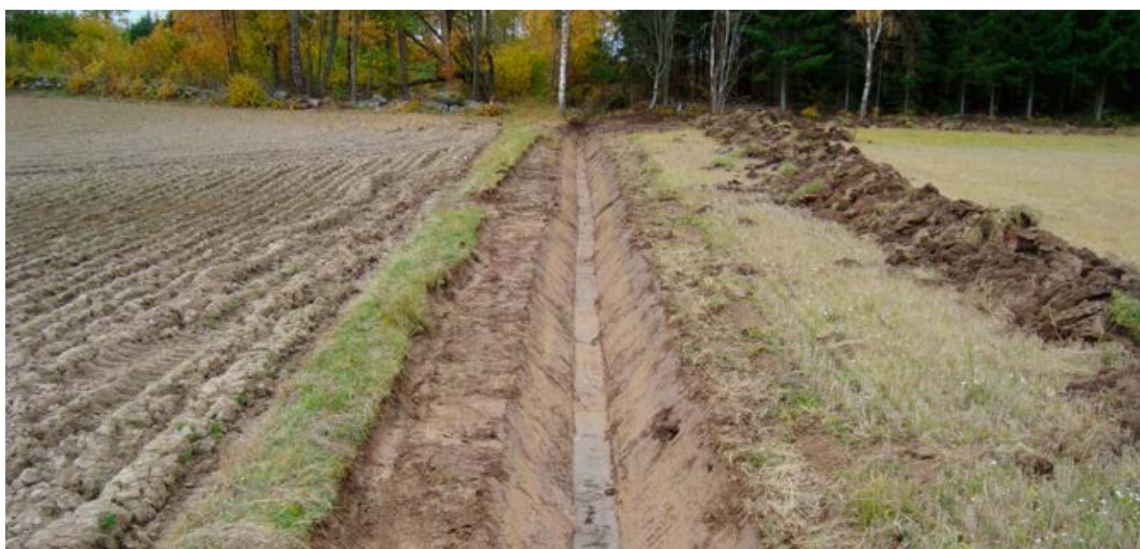
Med en profilskopa kan både ett tjockt sedimentlager och rotfilt tas bort samtidigt utan att skada slänterna (foto Rune Carlsson).
