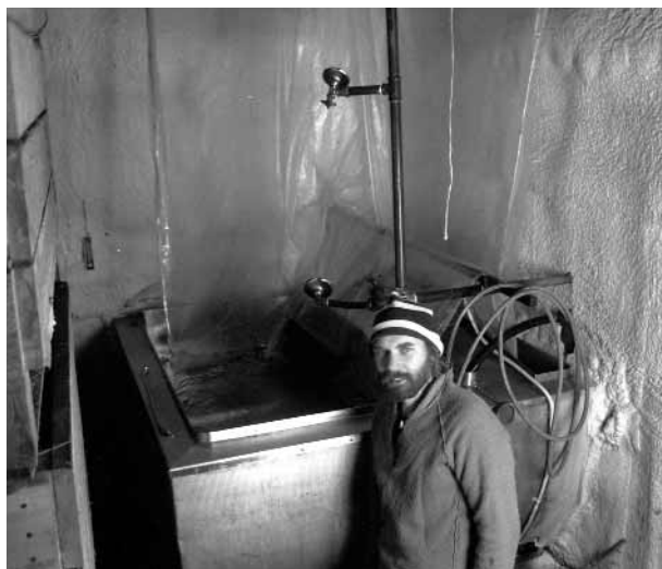
Figur 1. En hemmagjorda kyl- och fuktanläggning. Det är en begagnad mjölktank med kylaggregatet kvar som är stommen i anläggningen. (Foto: Lena Karlsson)
