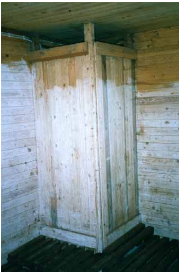
Figur 4. Fläktrumma för cirkulationsfläkten i en tork för tio ton. Högst upp horisontellt monterad sitter en fläkt från en f.d. spannmålstork och pressar luft ner genom trumman. Nertill mynnar trumman under spaltgolvet av trätrall.
