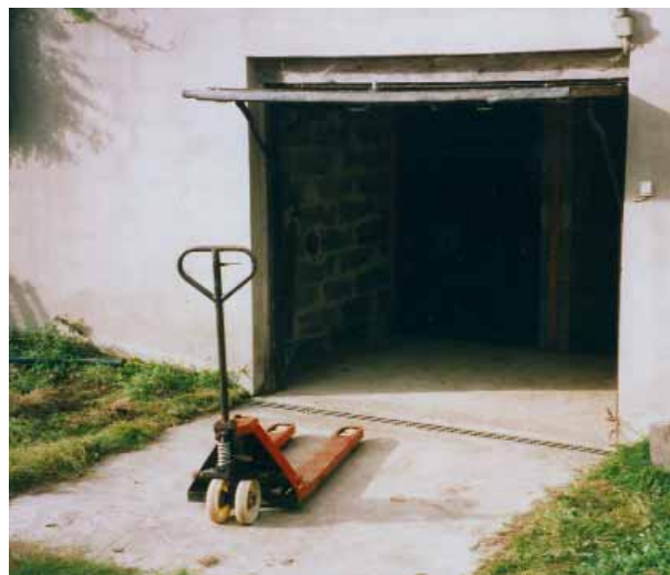
Figur 3. Källare med två kamrar för sammanlagt 30 ton. Stora lådor på pallar körs med traktor till omlastningsplattan utanför källaren. Hanteringen i källaren sker med handtruck. (Foto: Lena Karlsson)
