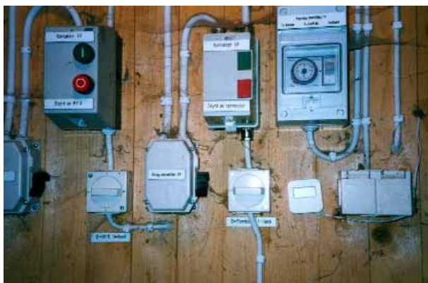
Figur 5. Reglerutrustning för den beskrivna styrningen av temperatur och luftfuktighet i löktorken under torkning och lagring. Kostnaden är 20–25 000 kr. Det går att sköta passningen manuellt för att komma ner i investeringskostnad. Man får då själv läsa av termometer och hygrometer och slå från och till de olika fläktarna. Detta kräver dock ett visst springande och passande, och klimatet kan ändå inte bli lika optimalt som automatiken. (Foto: Lena Karlsson)
